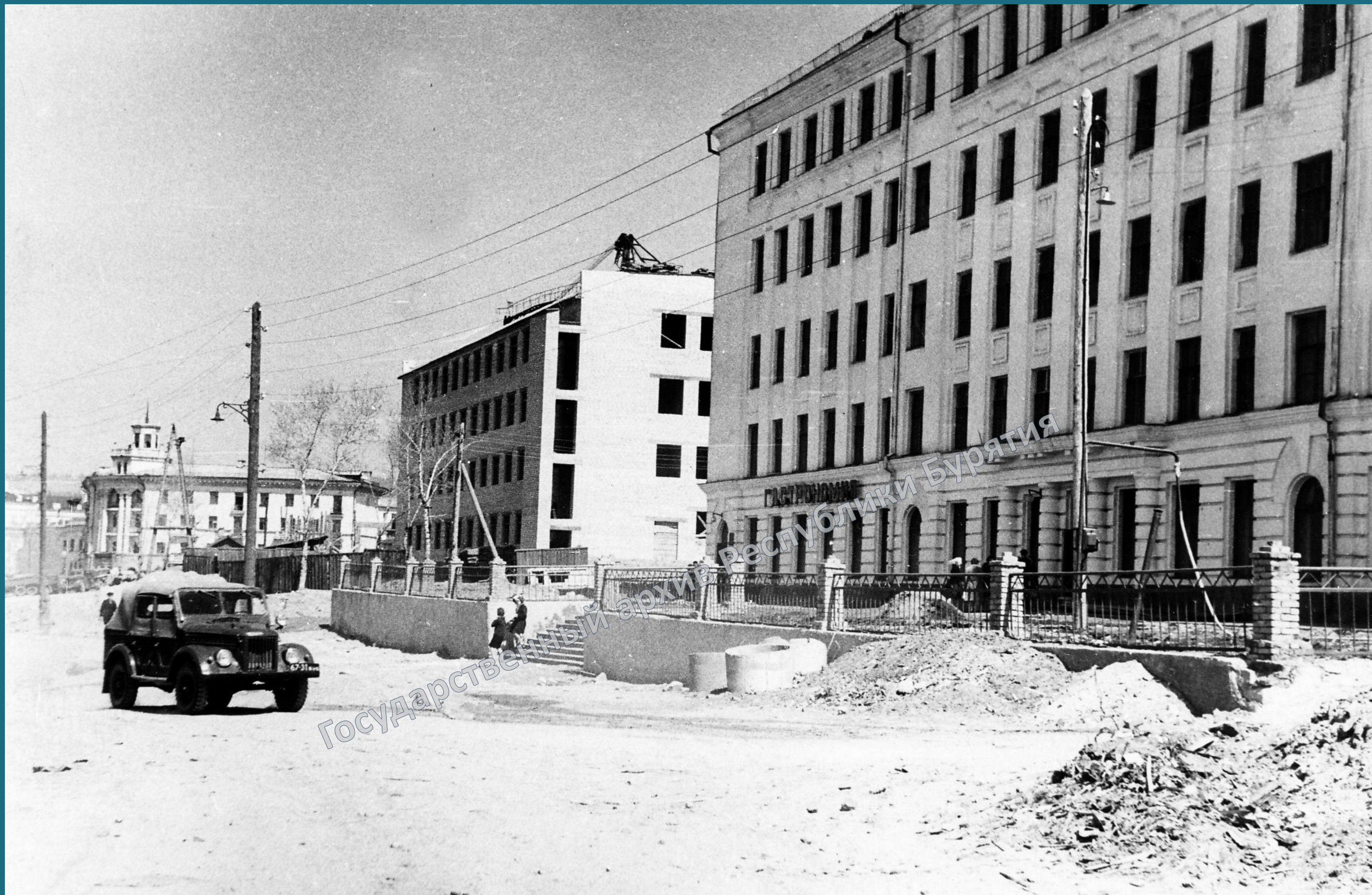
Строительство здания Улан-Удэнского музыкального училища им. П.И. Чайковского на Проспекте Победы. 1965 г. Фотофонд ГАРБ
